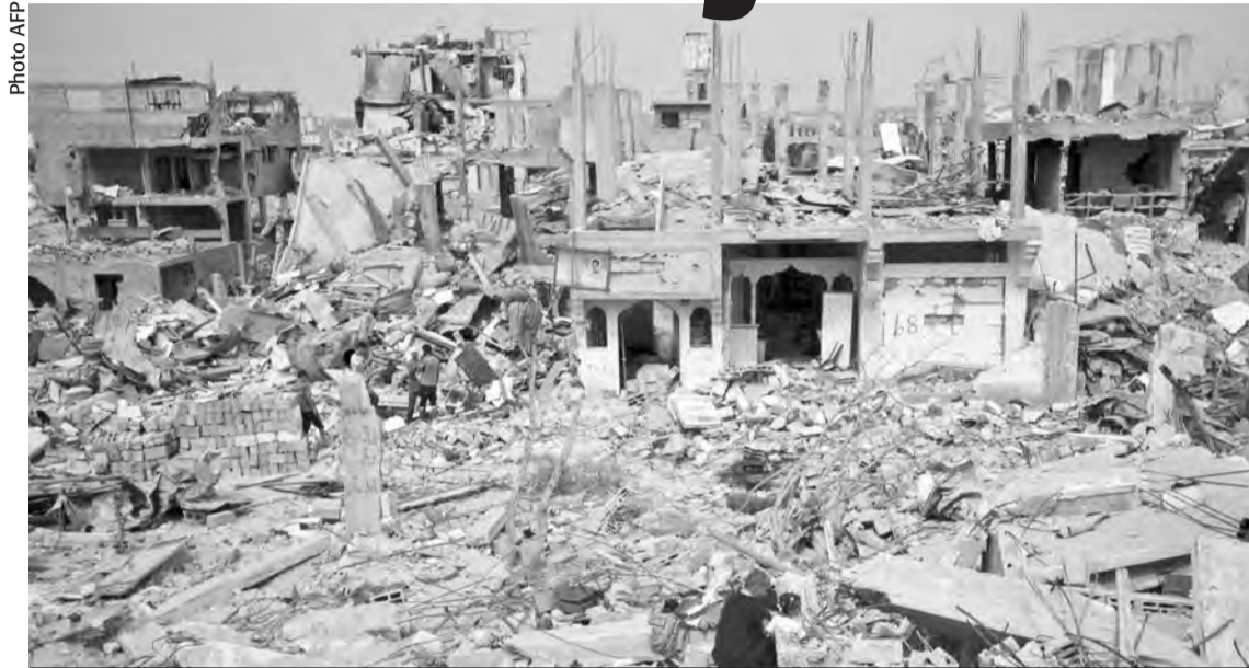
Gaza, le 11 octobre dernier : un vaste champ de ruines dans lequel dix-huit mille maisons et bâtiments ont été complètement détruits.
