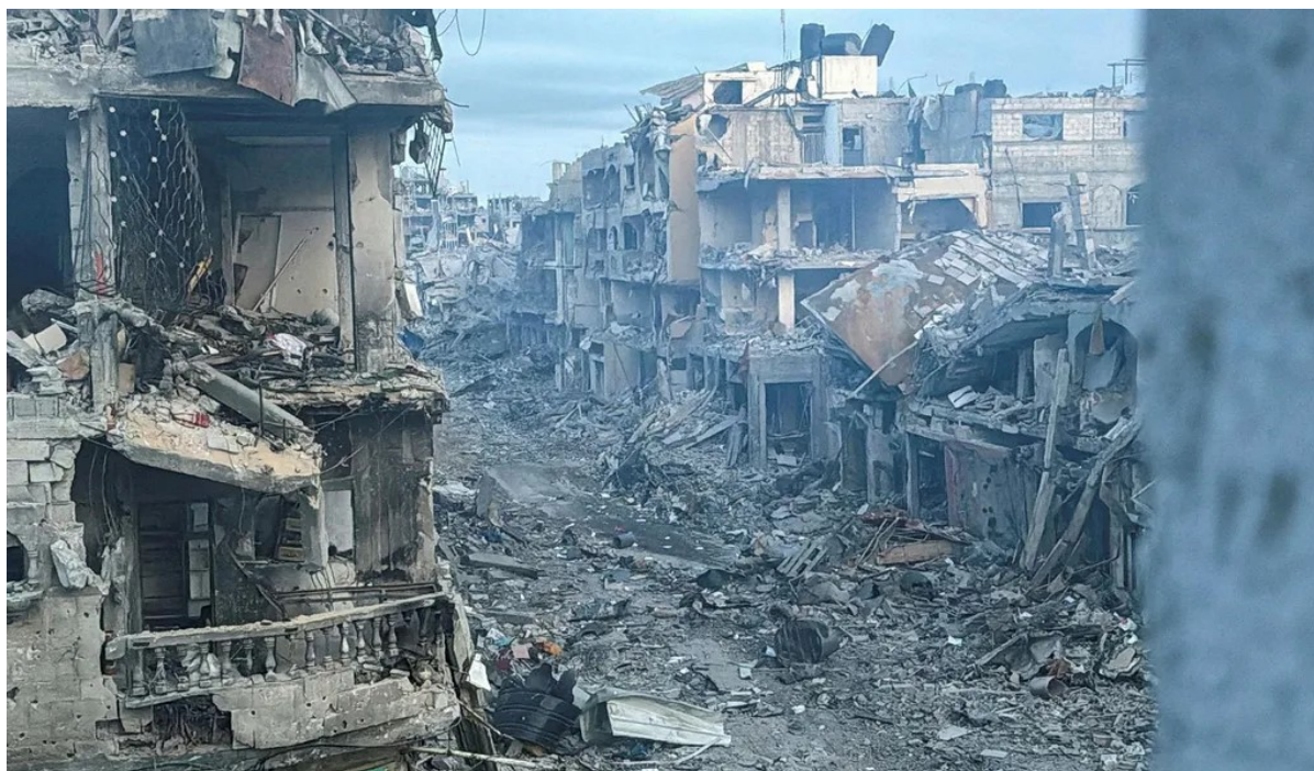
Les maisons palestiniennes sont gravement endommagées à Beit Lahiya, dans le nord de la bande de Gaza, la semaine dernière. Credit: Stringer / Reuters
