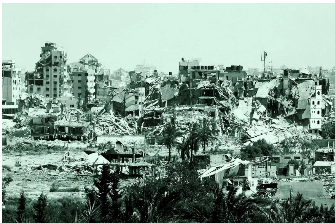
Maisons détruites dans la zone du corridor Netzarim, avril. Crédit: Ashraf Amra / ANADOLU / Anadolu / AFP
