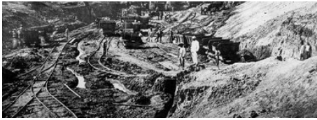
Construction du canal de Suez
